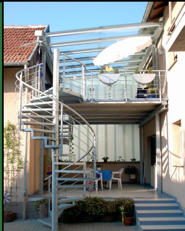
Stahlbaukon- struktion als Verbindungs- balkon zwischen zwei Gebäuden Mit angesetzter Spindeltreppe Überdachung aus VSG Glas Rückseitiger Sichtschutz aus VSG Milchglasscheiben
