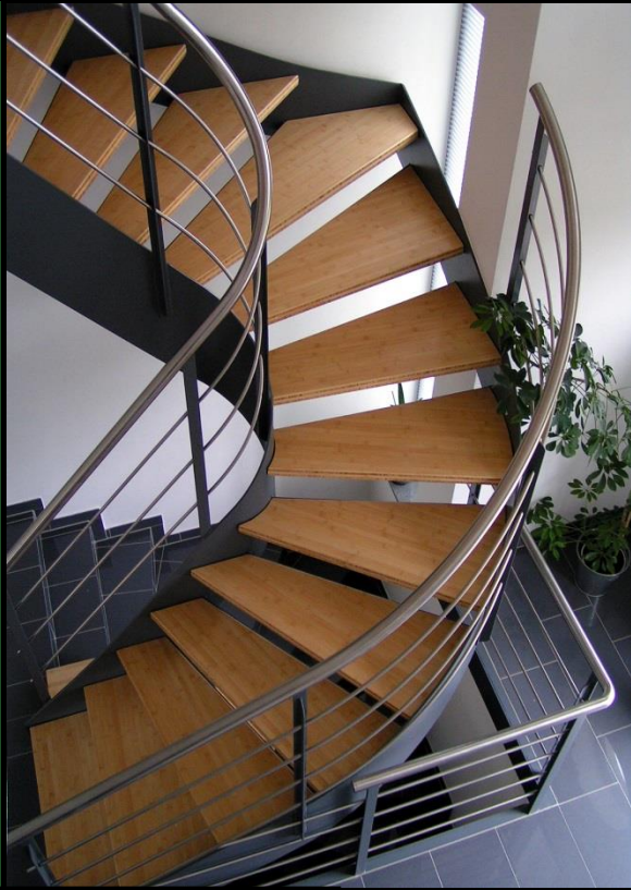
Flachstahlwangen- treppe T- Stützen Geländer mit Edelstahlhandlauf Trittstufen i in Massivholz Bambus
