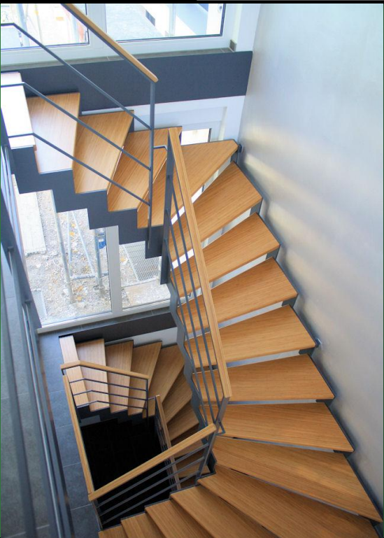
Abgetreptt gelaserte Flachstahlwangen- treppe Geländer aus Flachstahlstützen, mitlaufende Füllstäbe und Holzhandlauf Trittstufen in Massivholz Bambus
