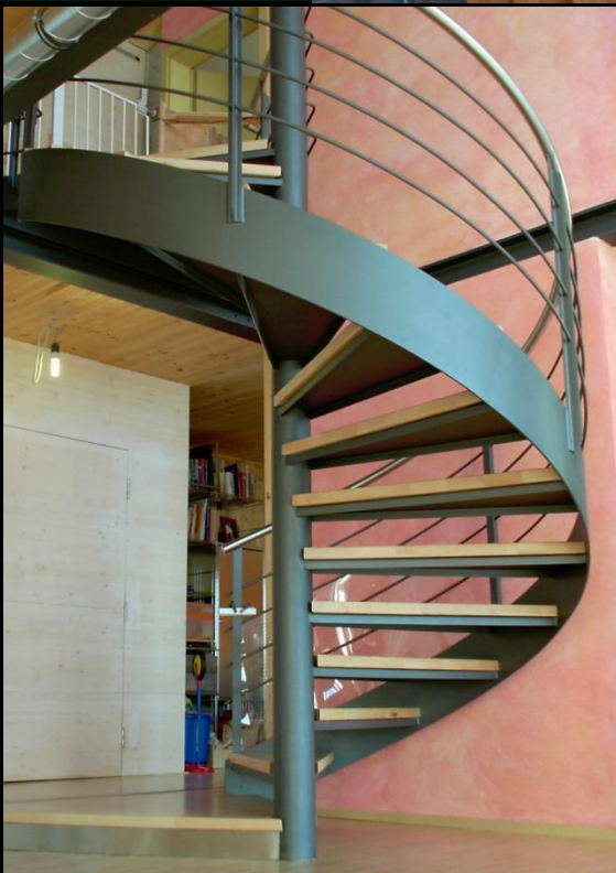
Spindeltreppe mit Flachstahlaußen- wange T- Stützen Geländer mit Edelstahlhand- lauf Trittstufen in Massivholz Kanadischer Ahorn
