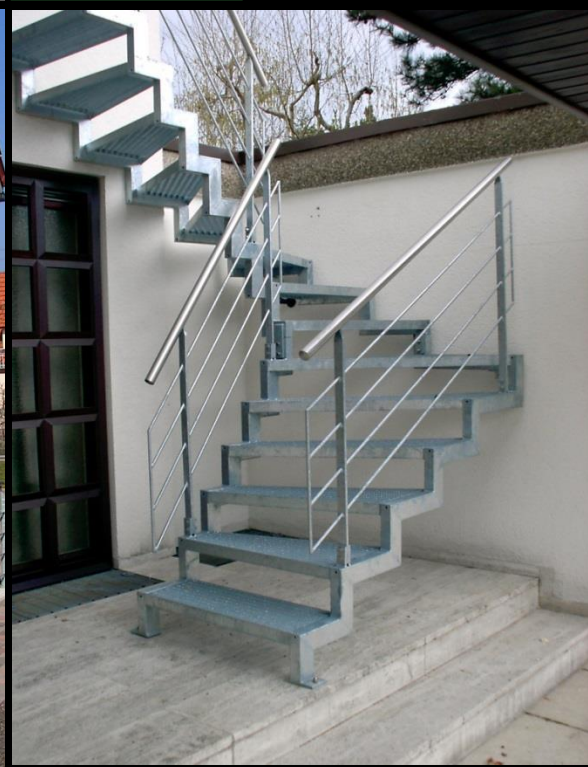
Rechteckrohr- treppe Flachstahlstützen- geländer mit Edelstahlhandlauf Trittstufen aus Gitterrost Maschenweite 30/10
