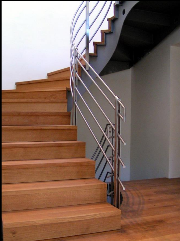
Flachstahlwangen- treppe als Sägezahn mit Tritt- & Setzstufen aus Blech Volledelstahl- geländer Tritt - & Setzstufen in Massivholz Eiche blockverleimt geölt
