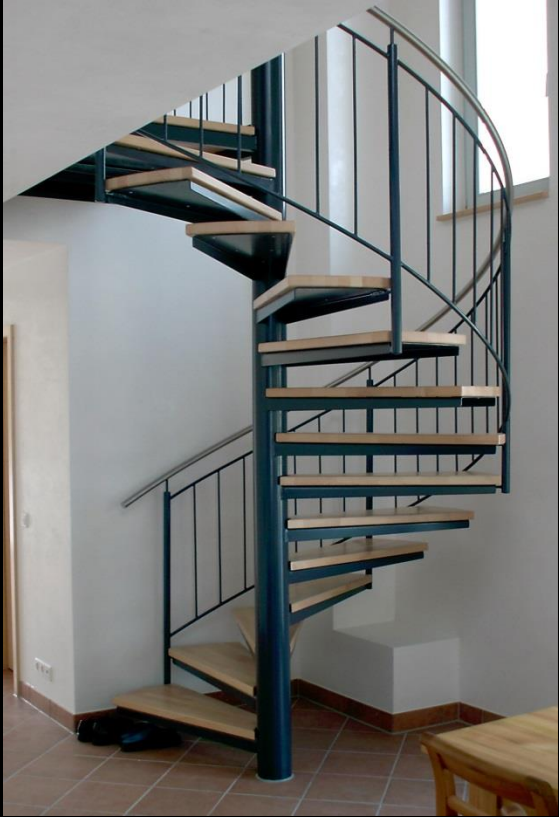
Spindeltreppe Rundrohrstützen- geländer mit Ober- & Untergurt sowie senkrechte Füllstäbe Trittstufen in Massivholz Buche stabverleimt
